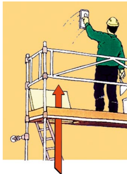
Durchstieg vor Arbeitsbeginn schließen
